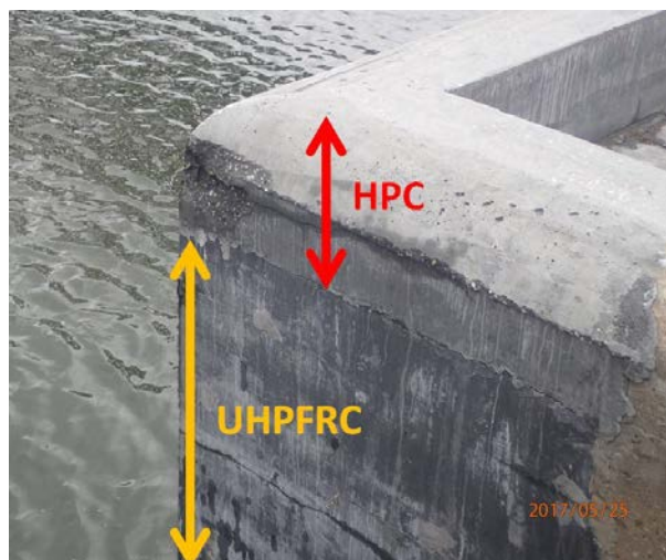
Fig. 13 Réparation de coins de mur avec le BFUP et HPC
