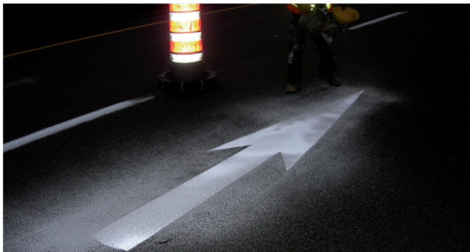
Figure 20 Rétroreflexion problématique d'une flèche
