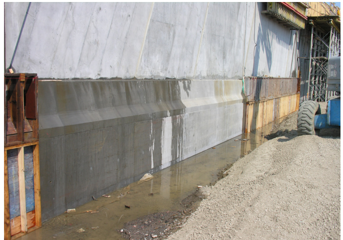
Photo 4 : Glissière ancrée après le décoffrage (Québec, 21 août 2013) Source : Nadia Pouliot
