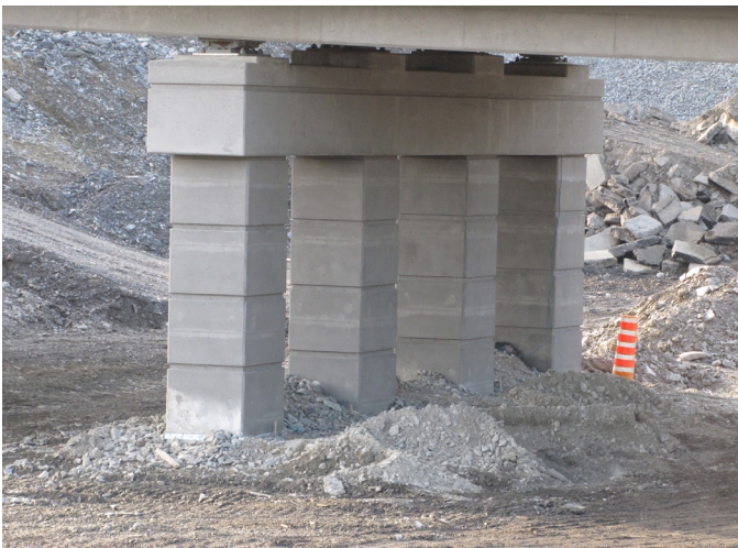
Photo 2 : Pile centrale après bétonnage (Sherbrooke, 4 novembre 2011) Source : Olivier Bonneau
