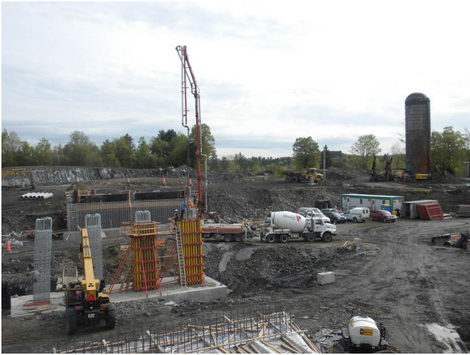
Photo 1 : Bétonnage des colonnes de la pile centrale (Sherbrooke, mai 2011, chaire de l'Université de Sherbrooke) Source : Olivier Bonneau
